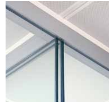
Revolution 54 Plus Head channel & fin
